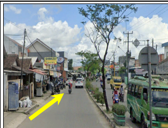
Lokasi Rencana JDU Pipa HDPE SDR 17/PN 10 - ND Ø 12" (Ruas Jl. Sunan Kalijaga - Jalan Provinsi - HDD)
